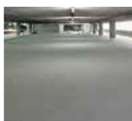
6. След това повърхността се завършва с Triflex Cryl Finish 209.
