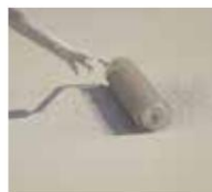
4. ... и разнесете равномерно с помощта на Triflex Special Roller.
