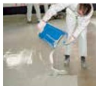
3. Полага се саморазливна замазка Triflex DeckFloor...
