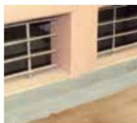
2. Детайлите са хидроизолирани с Triflex ProDetail.
